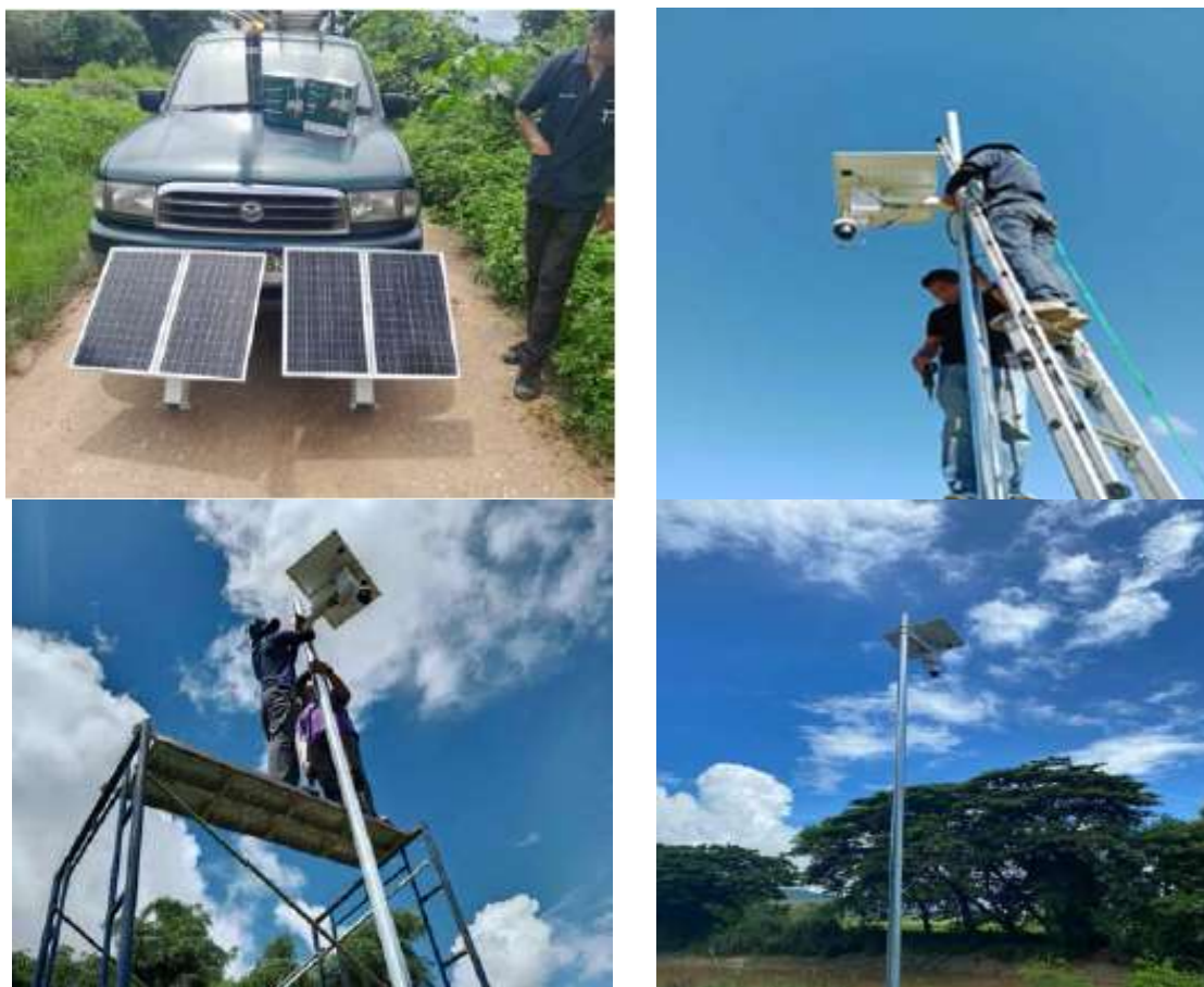
รูปที่ 5.12-1 กิจกรรมติดตั้งกล้องวงจรปิด พร้อมอุปกรณ์ในพื้นที่โครงการอ่างเก็บน้ำแม่เงิน
